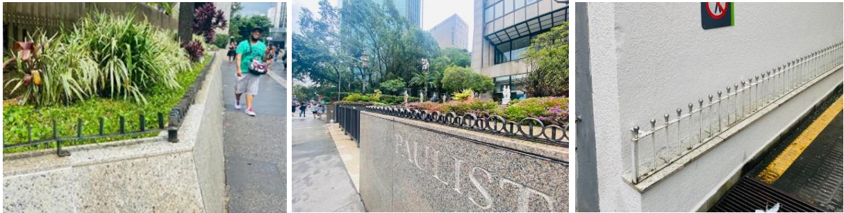
Figuras 2, 3 e 4 - Dispositivos da arquitetura hostil tipo pino
