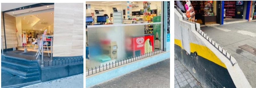
Figuras 5, 6 e 7 - Dispositivos da arquitetura hostil tipo pino
