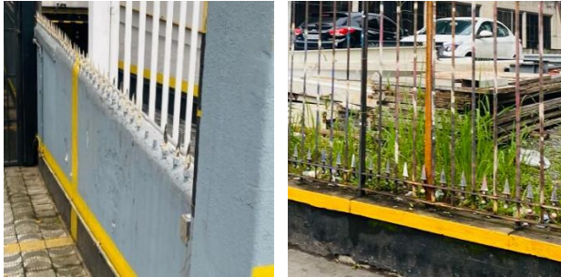
Figuras 11 e 12 - Dispositivo da arquitetura hostil tipo espeto
