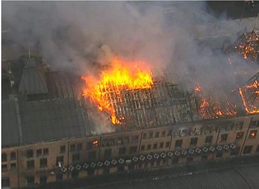
Figura 9. Incêndio no Museu da Língua Portuguesa
