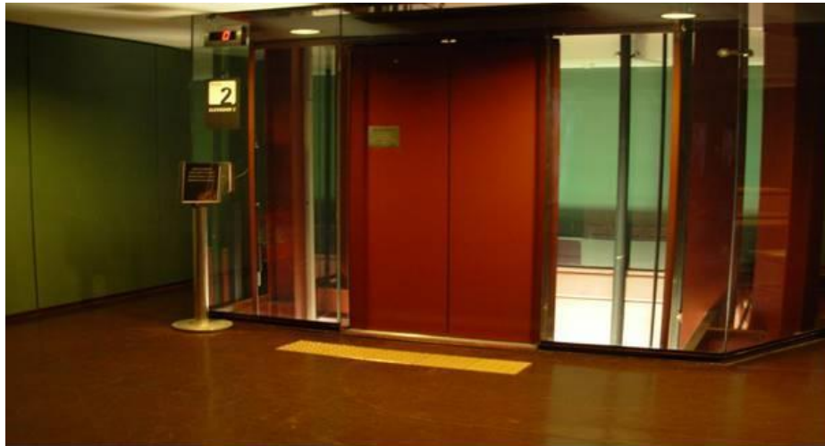
Figura 7. Acesso ao elevador
